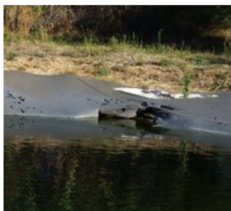
Photographies 17 et 18 : le bassin n°2 de lagunage de la STEP de Combaillaux. (On notera deux types de dégradations de la géo-membrane : une déchirure de tension qui s'agrandit régulièrement à fleur d'eau (d'où un écoulement) et des points de perçage plutôt dus aux UV.)
