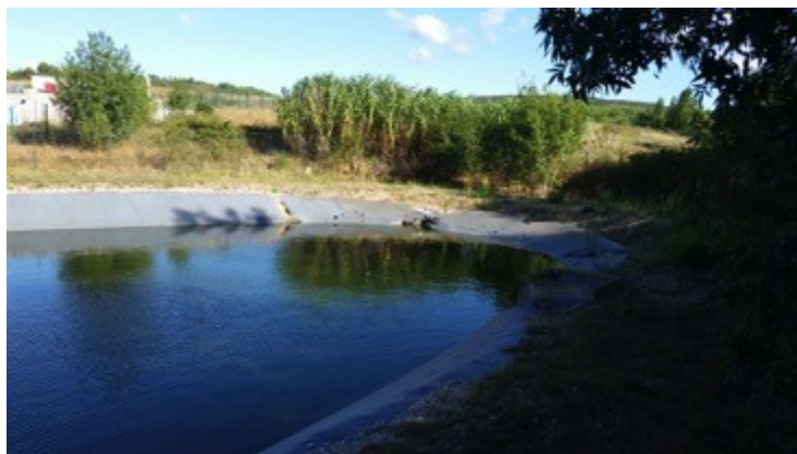
Photographies 17 et 18 : le bassin n°2 de lagunage de la STEP de Combaillaux. (On notera deux types de dégradations de la géo-membrane : une déchirure de tension qui s'agrandit régulièrement à fleur d'eau (d'où un écoulement) et des points de perçage plutôt dus aux UV.)
